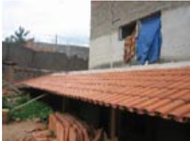
Tak byggt för att skydda ugnen!
